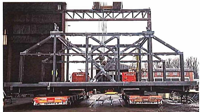
Die Konstruktion der Fahrfläche verließ am vergangenen Mittwoch die Fertigungshalle. Der Transport erfolgte mit zwei Schwerlasttransportern.
