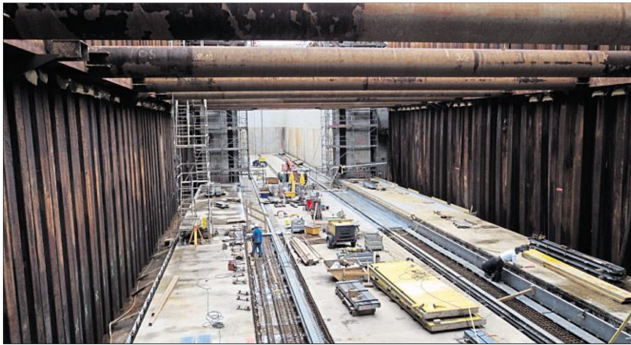
Eine vergleichbare Dimension wie die Kaiserschleuse in Bremerhaven (hier die Torkammer mit Schienenanlage) weist das geplante Projekt im Nord-Ostsee-Kanal auf. Für diese größte Schleuse Europas konstruiert, fertigt und montiert die Weidener Maschinenbaufirma Hermann erneut die komplette Antriebstechnik. Bild: hzf
