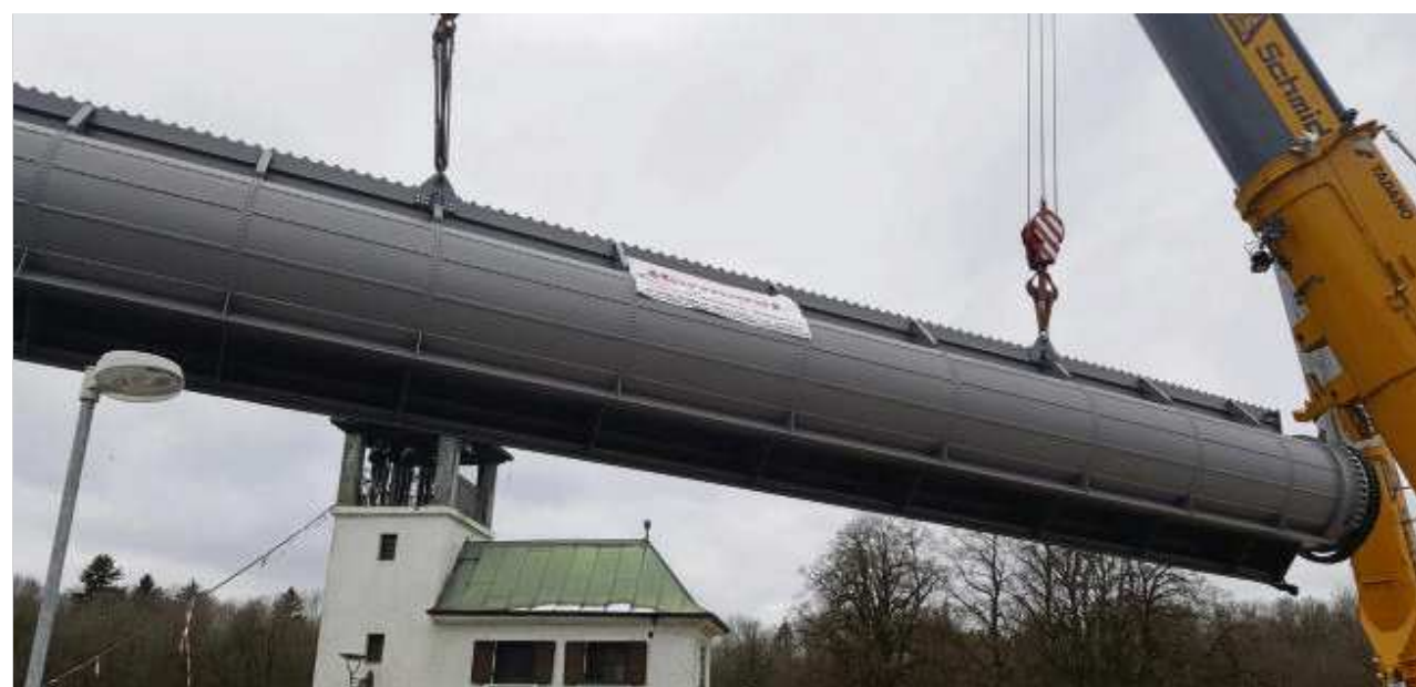
Ebenfalls „made in Weiden“: Am 23. Januar erfolgte die Installation einer 22 Meter langen und 38 Tonnen schweren Walze für ein Wehr der Lech-Kraftwerke in Augsburg. Die Firma Hermann restaurierte das denkmalgeschützte Objekt (Nachbildung als Nieten-Konstruktion).
